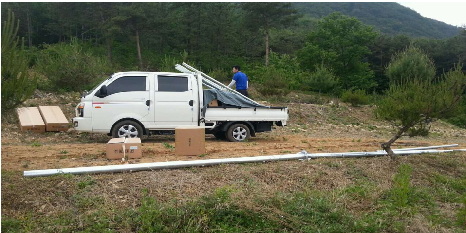
[그림 3-2] 통신주의 차량 운반(예시)
