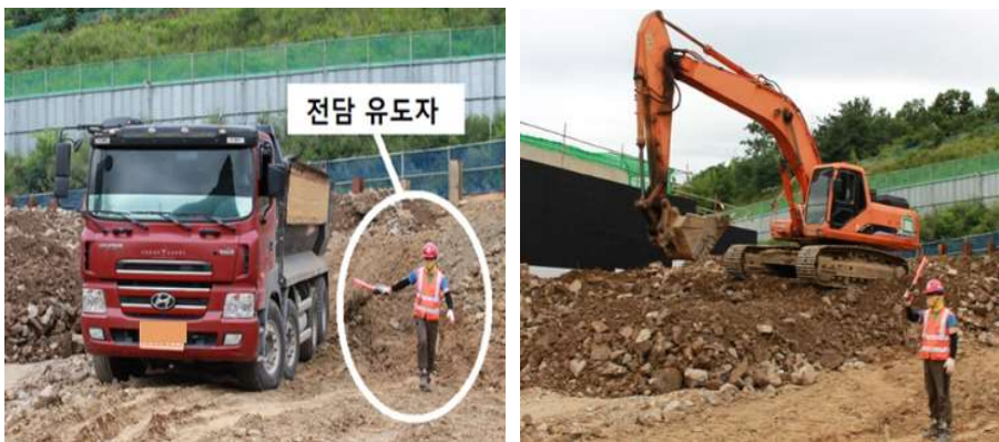
[그림 2-13] 기계장비 유도원 배치(예시)
