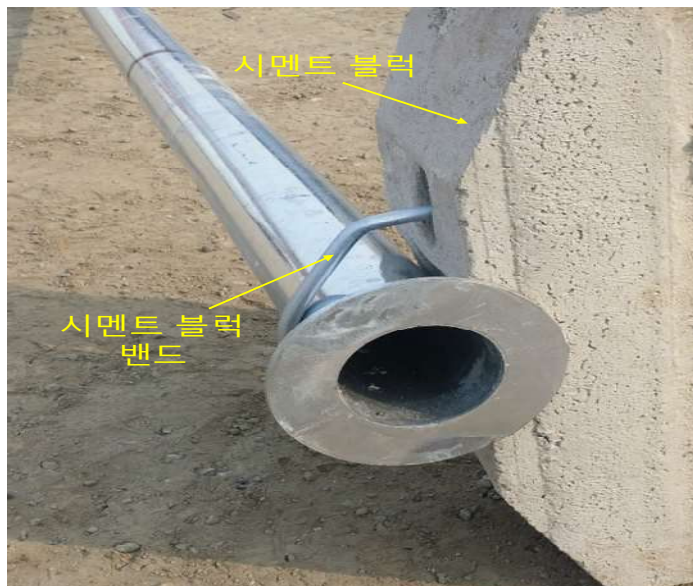
[그림 3-15] 시멘트 블럭 설치 방법
