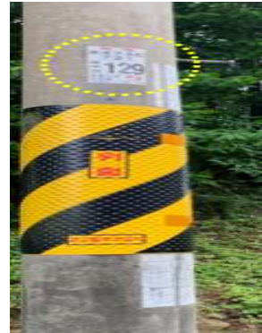
[그림 3-17] 통신주 번호 표찰 설치(예시)
