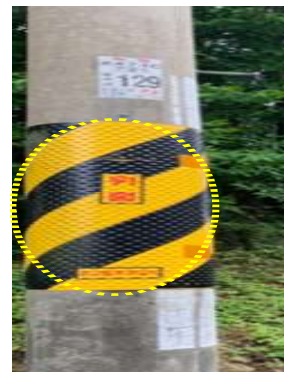
[그림 3-18] 통신주 보호용 안전표시판 설치(예시)
