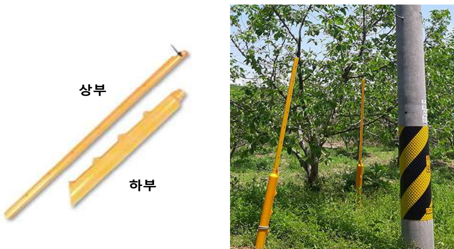
[그림 4-11] 지선 보호 덮개 설치
